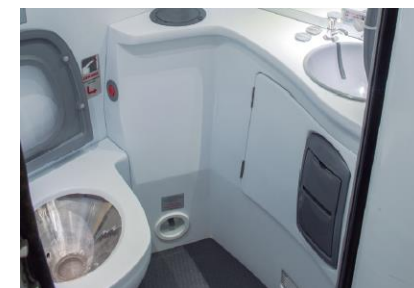
Nuevo sanitario, facilidad de mantenimiento y termoacústico
